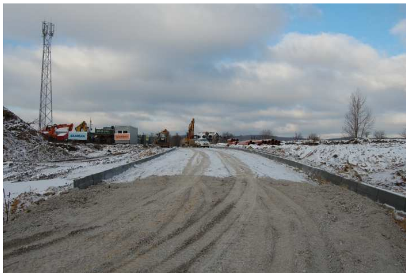
Zdjęcie 3. Ul. Drogowców w Redzie w trakcie przebudowy (widok w kierunku Wejherowa).
