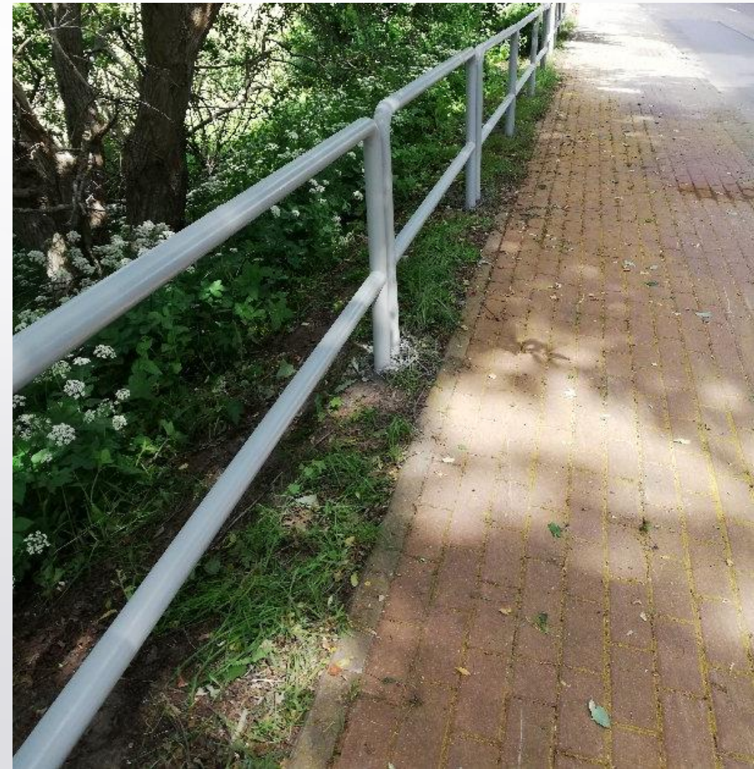
Zadanie 2: Renowacja zabezpieczeń antykorozyjnych barier ochronnych w ciągu drogi powiatowej nr 1446G w m. Rybno
