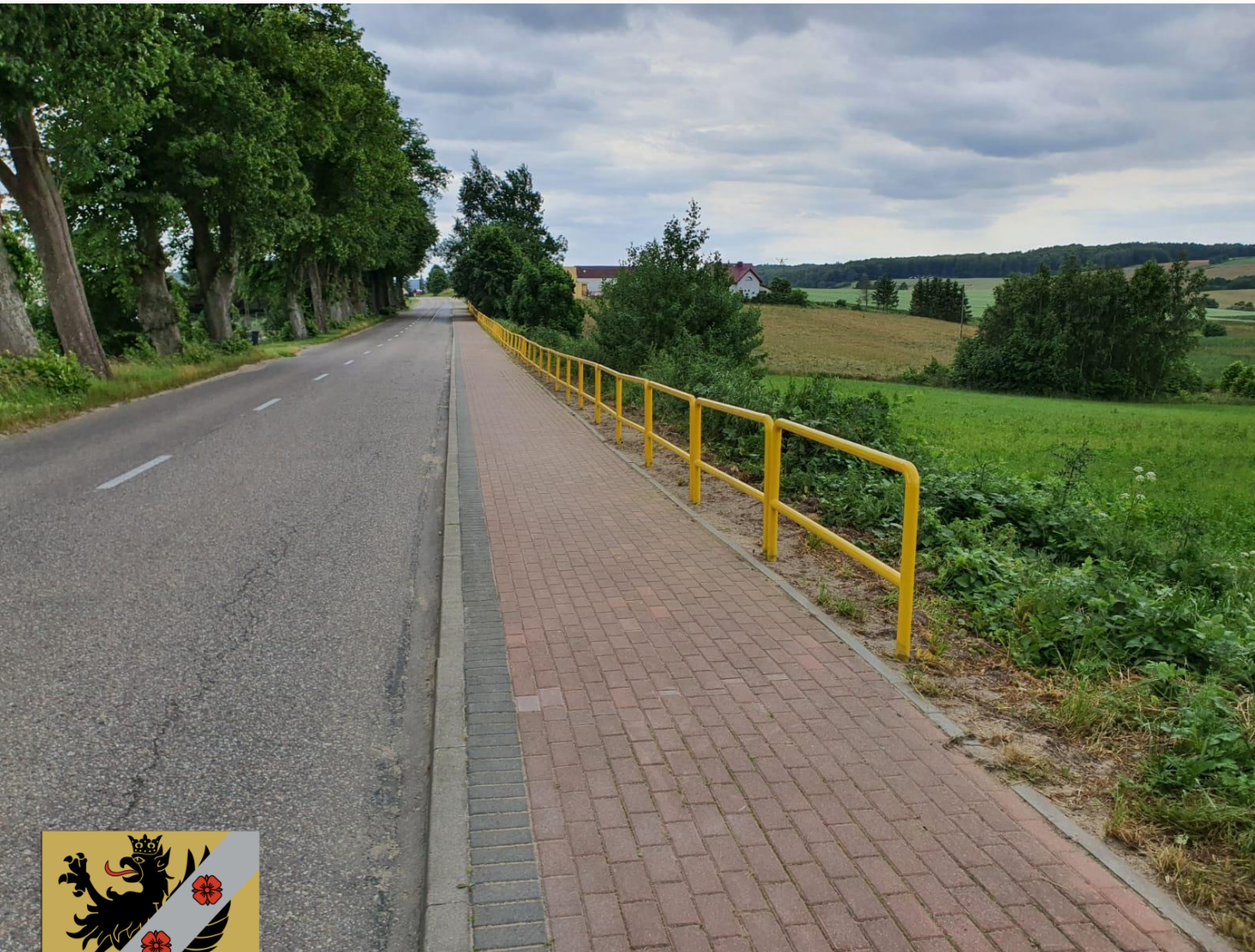
Zadanie 1: Naprawa chodnika w ciągu drogi powiatowej 1446G w m. Rybno
