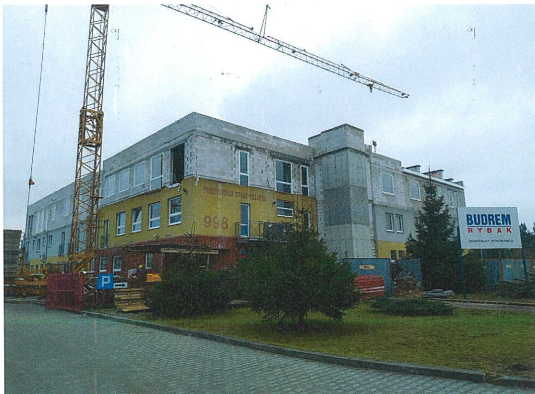
Zdjęcia: Przebudowa budynku Jednostki Ratowniczo – Gaśniczej nr 1 w Wejherowie
