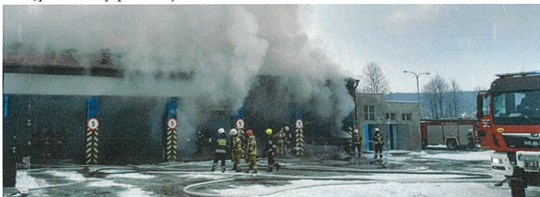
Zdjęcie: Pożar hali garażowo – warsztatowej MZK w Wejherowie.
