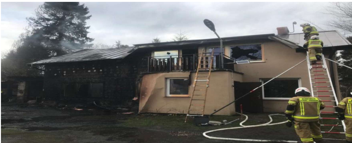
Pożar kompleksu budynków w Rybieniu
