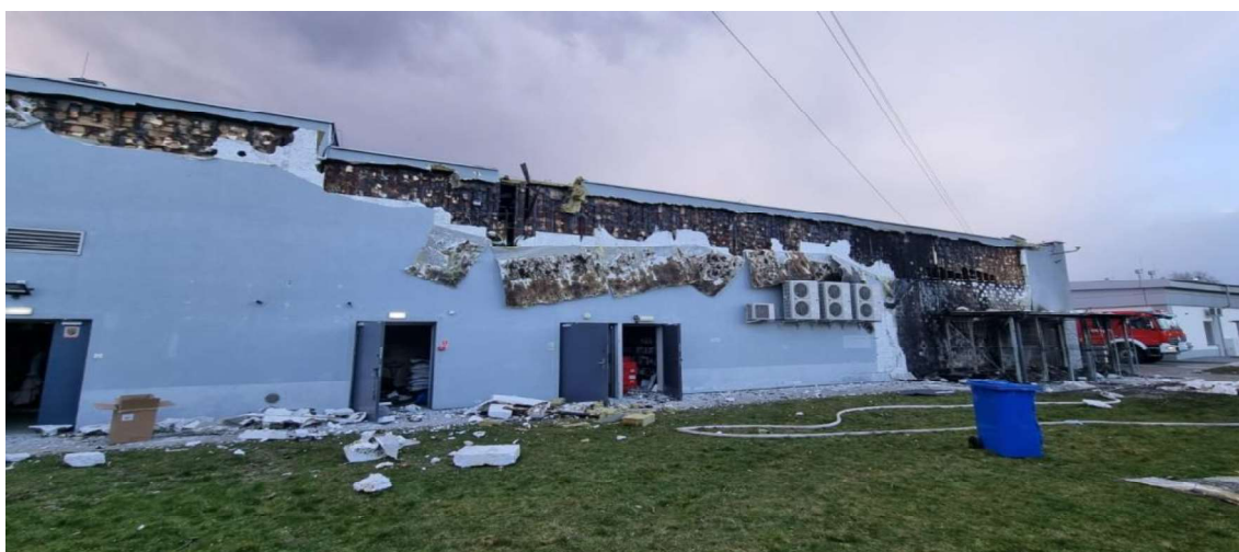
Pożaru budynku handlowo – usługowego w Rumii
