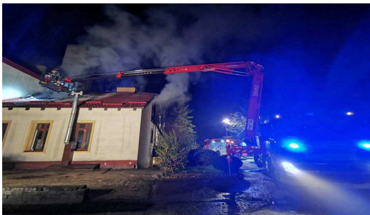
Pożar budynku Ośrodka Terapii Uzależnień w Smażynie
