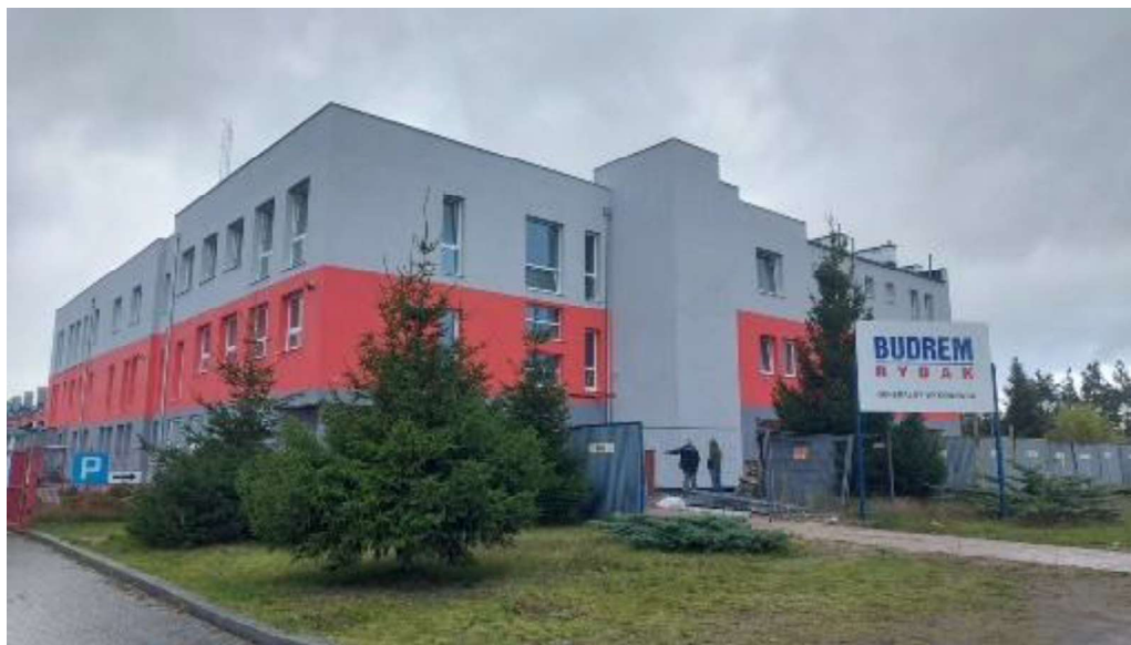
Zdjęcie: Przebudowa budynku Jednostki Ratowniczo – Gaśniczej nr 1 KP PSP w Wejherowie - grudzień 2022
