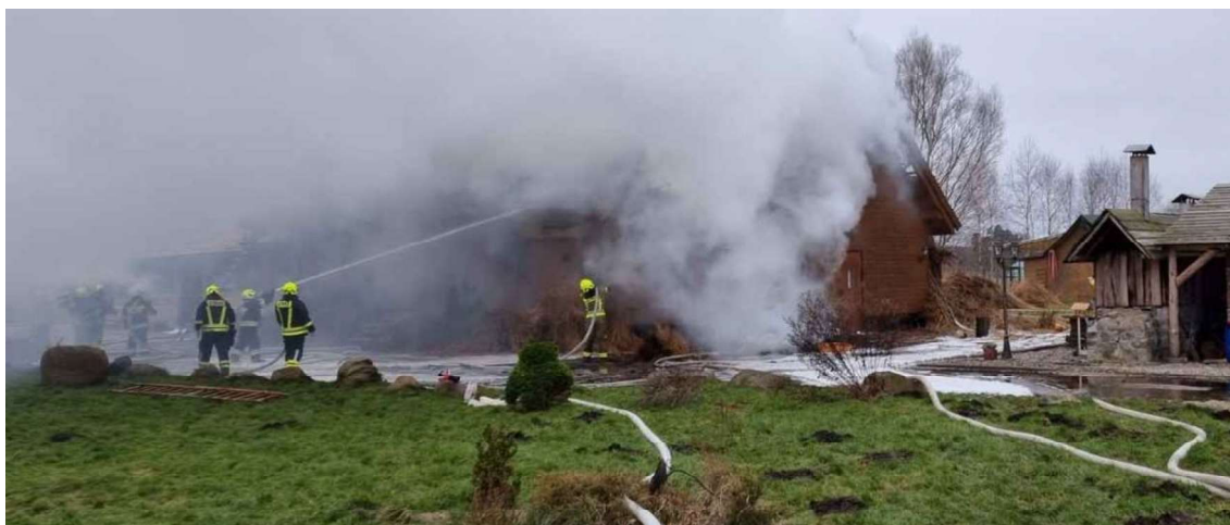
Pożar budynku usługowo - mieszkalnego w Kierzkowie
