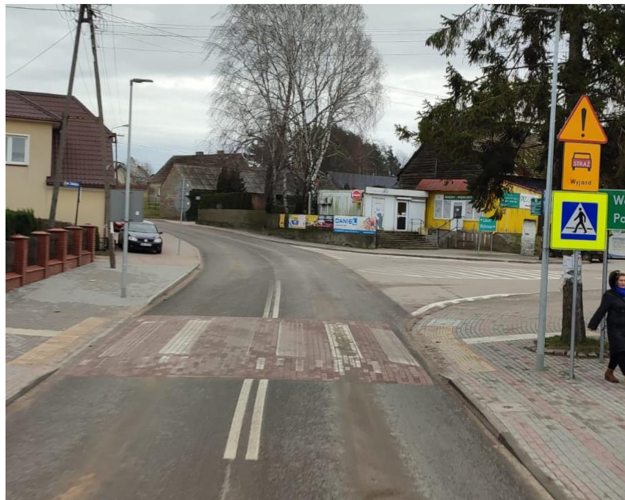
Linia (przejście dla pieszych przy Urzędzie Gminy)
