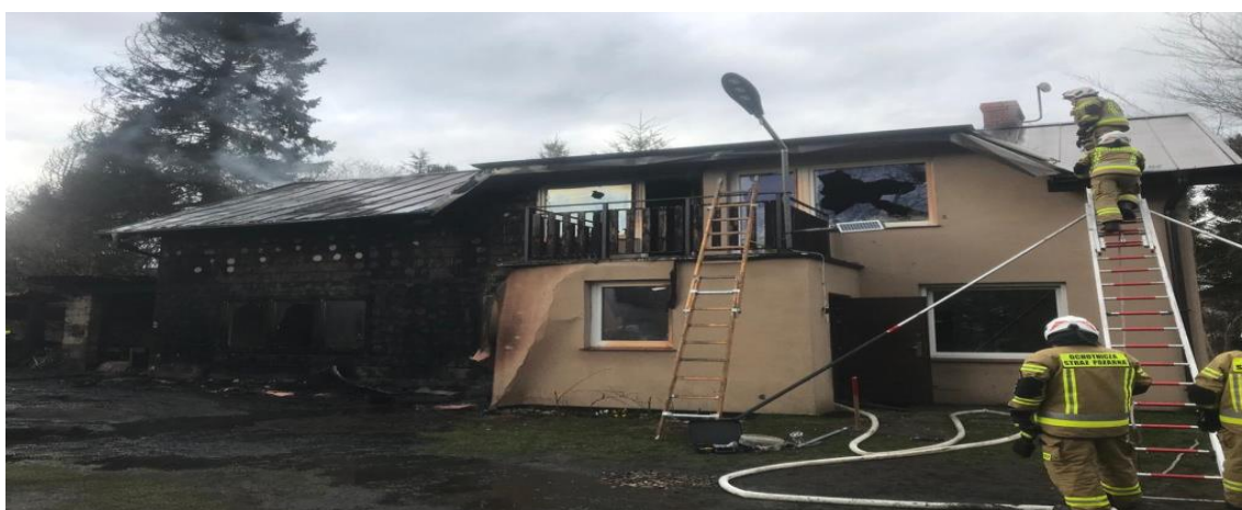
Pożar kompleksu budynków w Rybieniu
